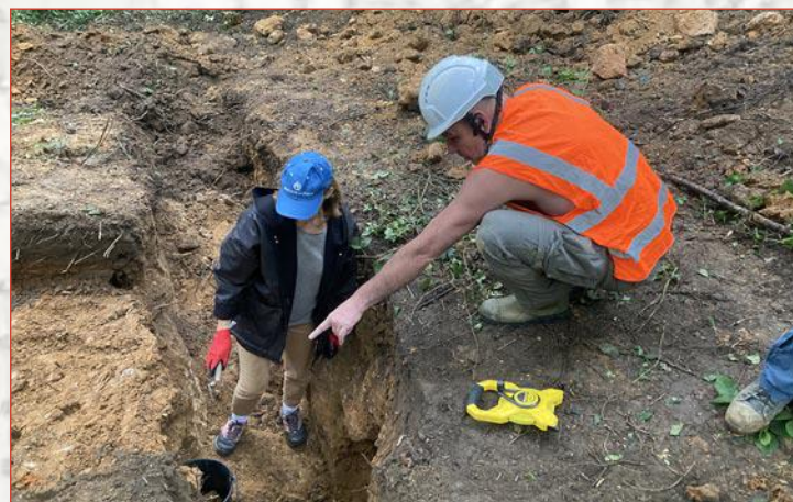
Fouille du bassin (13,7.21) - Cliché Bruno Bentz
