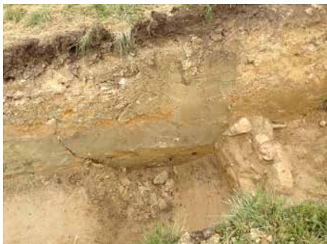
**Fig. 10 Marly-le-Roi (Yvelines). Corroi de glaise du « bassin des Nappes », 1684. Fouilles archéologiques, mai 2013. © B. Bentz.**
