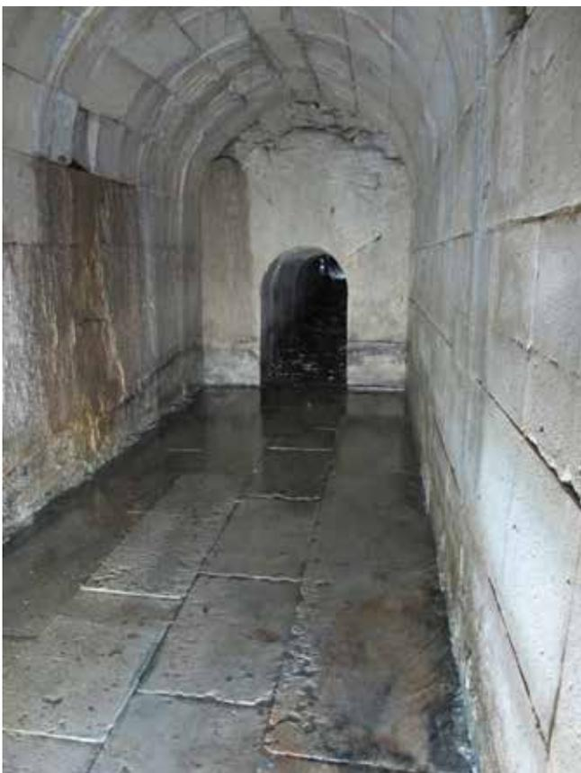
**Fig. 17 Marly-le-Roi (Yvelines). Chambre de décantation de l'aqueduc de « l'Abreuvoir », 1687, arrivée de la galerie des « Nappes ». État actuel. © S. Chaumier.**
