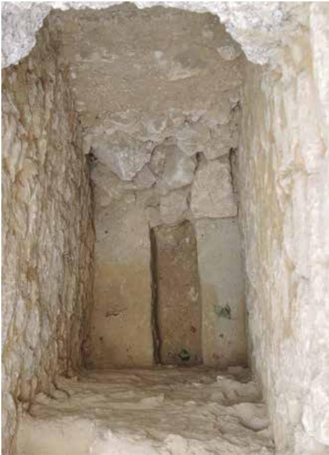
**Fig. 16 Marly-le-Roi (Yvelines). Liaison entre la cunette de la galerie des « Nappes », vers 1680, et le contre-mur du « bassin des Nappes », 1684. Fouilles archéologiques, juin 2013. © A. Heitzmann.**
