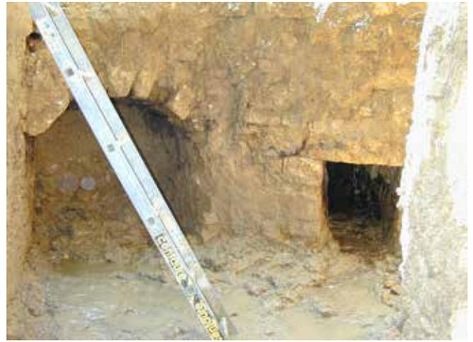
**Fig. 14 Marly-le-Roi (Yvelines). Chambre de l'aqueduc de la « Terrasse », 1679. Liaison entre la galerie provenant du pavillon royal (à gauche) et une pierrée (à droite) découverts en 2006 lors de travaux d'entretien du réseau hydraulique dans le parc de Marly réalisés par le Service des fontaines. © B. Bentz.**
